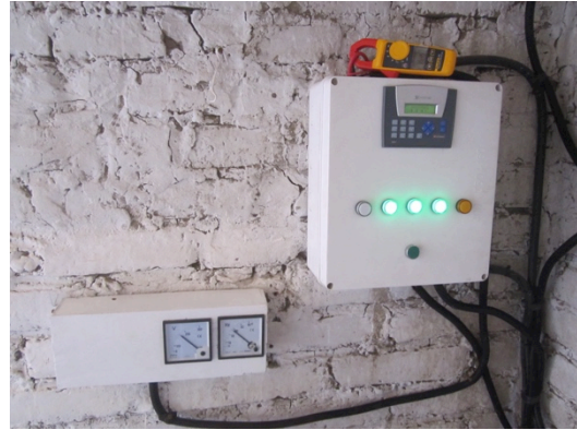
Figura 4: CONTROL DE BOMBAS E INSTRUMENTOS DE MEDICIÓN
