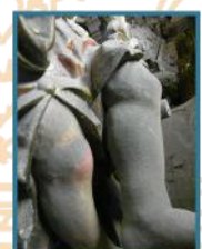
Acumulación de polvo en la superficie.
